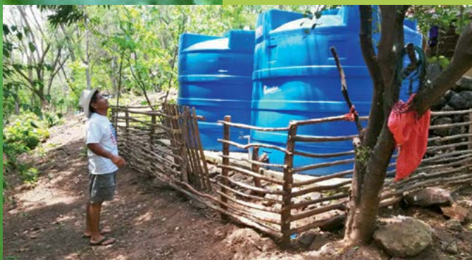
Estanques plásticos de 10 mil litros, Honduras.
