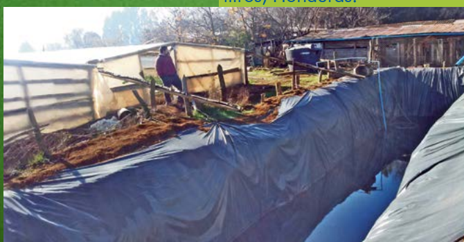
Estanques plásticos de 10 mil litros, Honduras.
